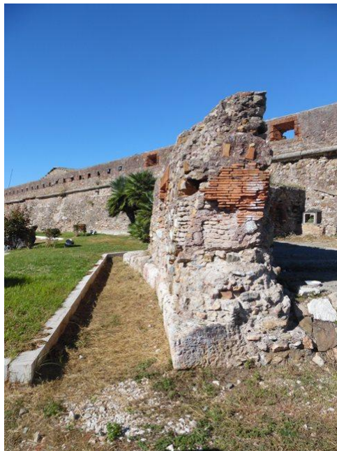
Parte del Cinquecentesco Bastione progettato dal Sangallo
